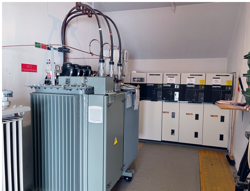
Mit regelbaren Ortsnetztransformatoren (RONT) lässt sich die Spannungsqualität im Netz halten. Überspannungen können mit ihnen vermieden werden.
